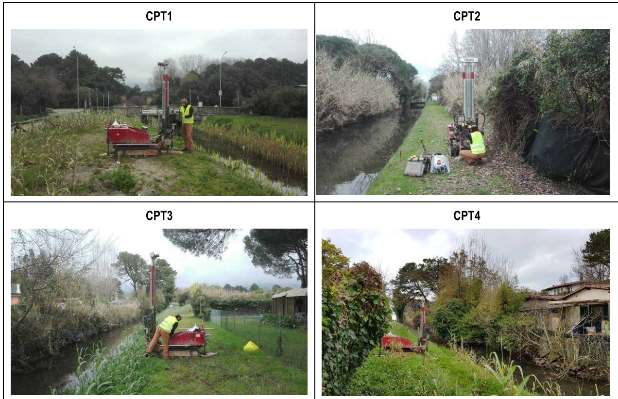
Figura n.10 - Fasi di esecuzione delle prove penetrometriche realizzate lungo le sponde del Fosso Poveromo.
