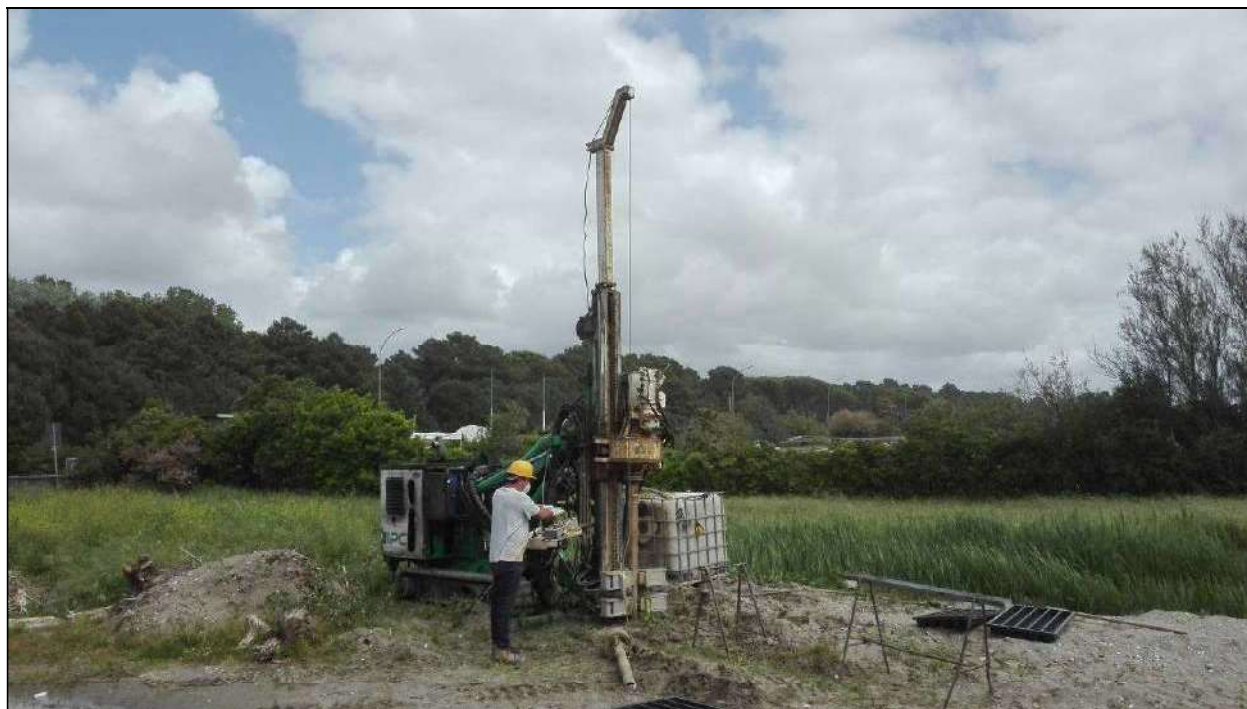
Foto 1: Postazione del sondaggio S1.
